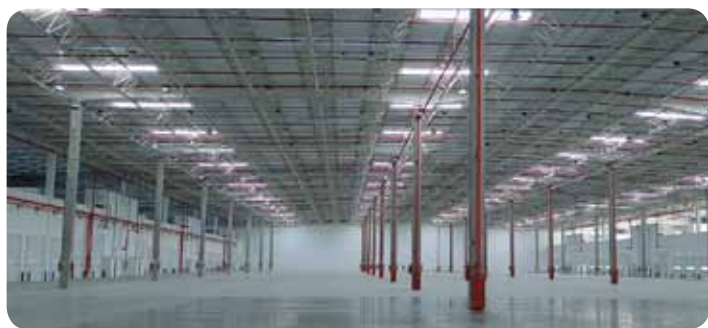
Pé direito de 12m e piso com sobrecarga para 5 Ton/m 2
