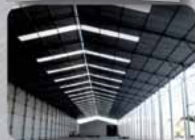
Coberturas 02 águas em zinco
