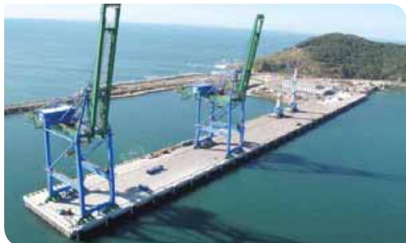
Porto de Imbituba: com investimentos de R$ 520 milhões, a Santos Brasil construiu dois berços de atracação e 3.000 m 2 de armazém coberto, além de adquirir equipamentos portuários
