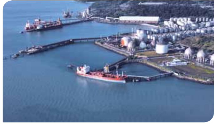
Porto de Aratu: responsável por 61% da receita da Codeba, o porto terá um novo terminal de granéis sólidos, voltado para minérios como ferro e manganês
