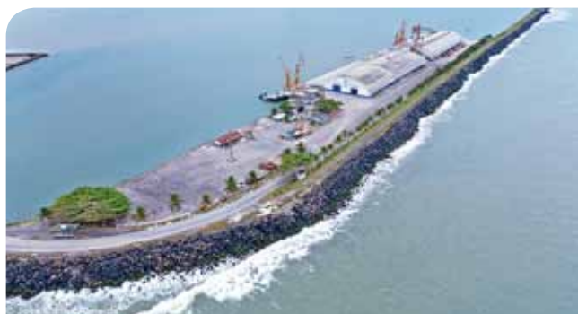
Porto de Ilhéus: investimentos na construção de plataforma de acostagem e aterro, acessibilidade, dragagem de aprofundamento e compensação ambiental
