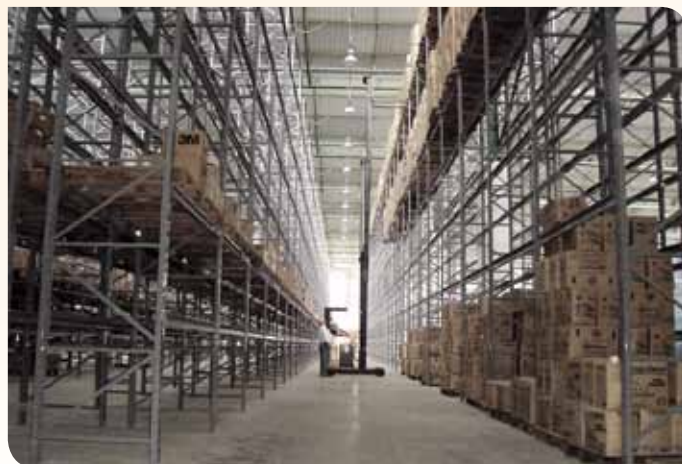
A introdução de novos condomínios industriais, nas mais variadas regiões do País, faz com que o segmento de armazenagem seja um dos mais aquecidos, devido aos grandes projetos
