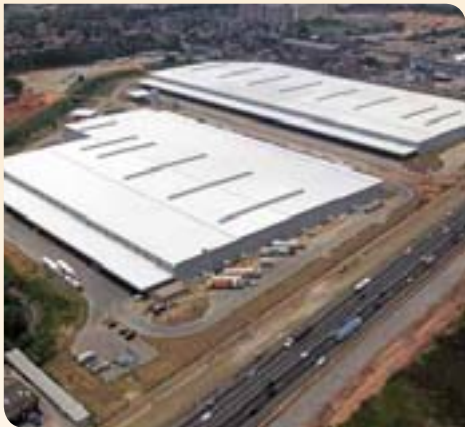
Centro de Distribuição com cobertura metálica fornecida pela Marko Sistemas Metálicos. Um dos principais produtos da empresa é o Sistema Roll-on
