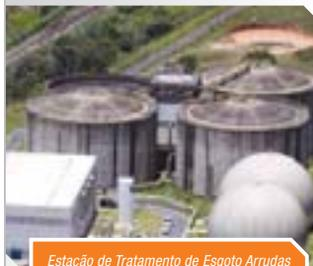
*Estação de Tratamento de Esgoto Arrudas da Copasa. O biogás já é aproveitado em uma de suas termelétricas, que ainda está em fase de testes*
