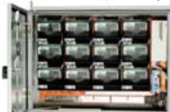
A solução Garnet funciona através de 12 medidores incorporados em um gabinete que, instalado no poste, impede o acesso não autorizado
