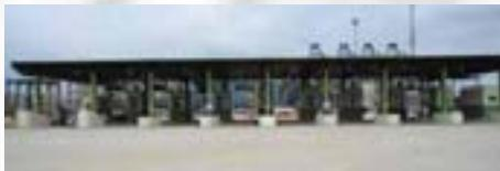
até 600 caminhões por hora, sendo metade na entrada e o restante na saída. O sistema auxiliará no recebimento e expedição dos contêineres, evitando gargalos que podem ocorrer neste tipo de operação. Todas as balanças já foram instaladas e a operação está prevista para o primeiro trimestre de 2013. Como o equipamento não usa vigas metálicas na estrutura, apenas concreto, o modelo é considerado único no mercado, segundo a Filizola.
