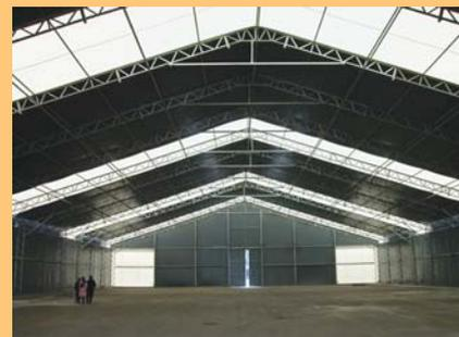
natural; nos galpões modulares, o cliente pode aumentar ou diminuir os vãos conforme a necessidade, depois de instalados; e podem ser acoplados a outros tipos de galpões, interligando os mesmos com calhas e tapadeiras.
