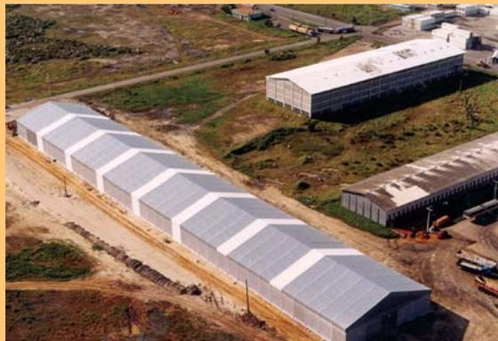
podendo ser instalados em todos tipos de pisos, desde que nivelados e compactados com estacas ou chumbadores; são considerados edificação transitória; suportam vento conforme ABNT NBR 6123; os tetos podem ser com lona de PVC translúcidos para maior incidência de luz
