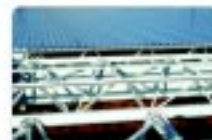
Sistema de Cobertura e Fechamento
