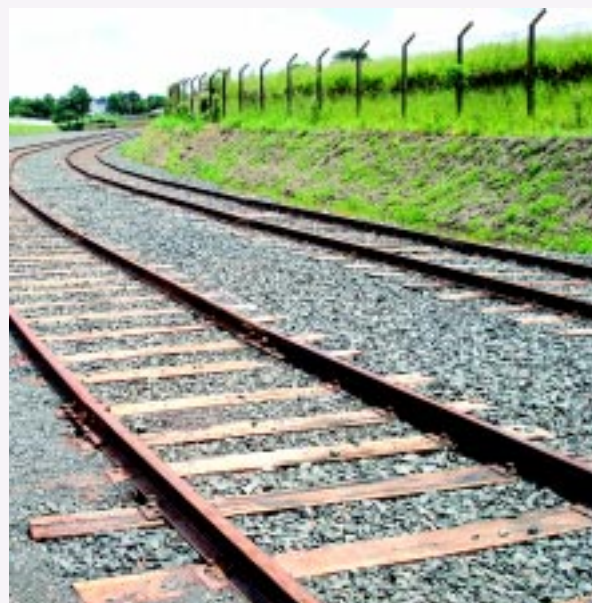
Novo ramal permite acesso direto aos terminais portuários da região sudeste
