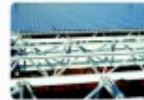
Sistema de Cobertura e Fechamento
