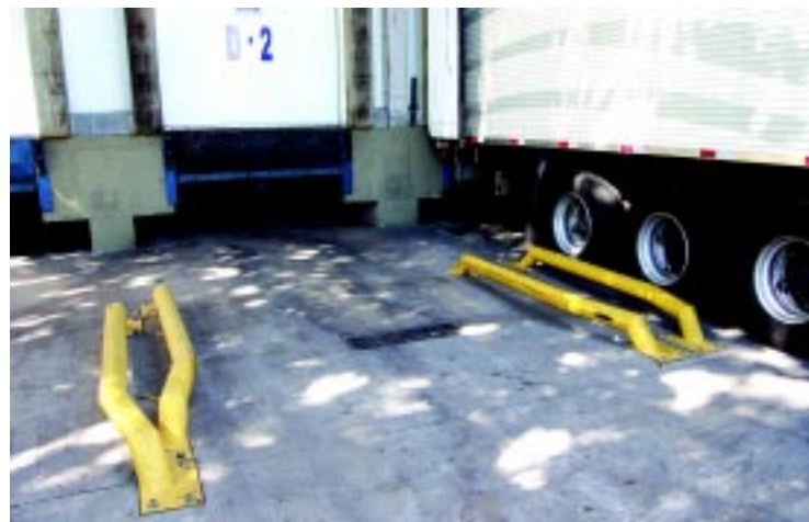
Os guia-rodas também garantem maior segurança na aproximação dos caminhões das plataformas
